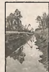
Прокладка газопровода в тайге.
